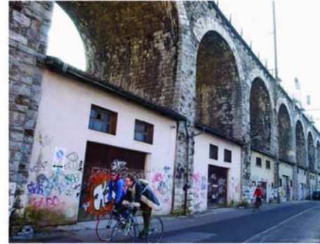
Hinterhofatmosphäre: Früher wurden die Bögen unter der Brücke als Warenlager oder Werkstätten genutzt.
