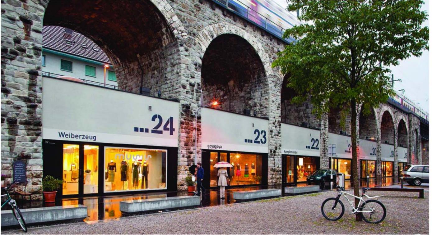
Flaniermeile: Unter den Bögen des Eisenbahnviadukts im Zürcher Kreis 5 werben trendige Läden um Kundschaft (siehe auch Bild rechts).
